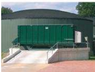
Žaliavos padavimo sistema automatiškai tiekia biomasę į talpyklas
