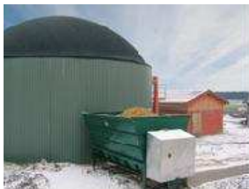
Dujų gamybos talpykla - biologinis reaktorius, kurio stogas kartu yra ir dujų talpykla - gazholderis
