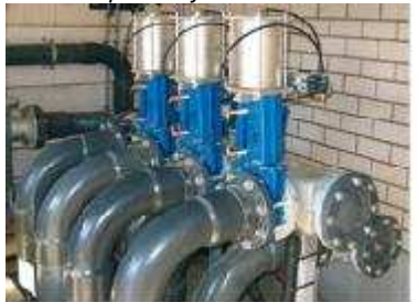
Siurblių ir vožtuvų sistema. Išmatuoti skystų substratų kiekiai yra automatiškai pumpuojami į biodujų reaktorių
