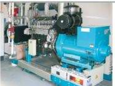
Kombinuotas el. energijos bei šilumos gamybos įrenginys
