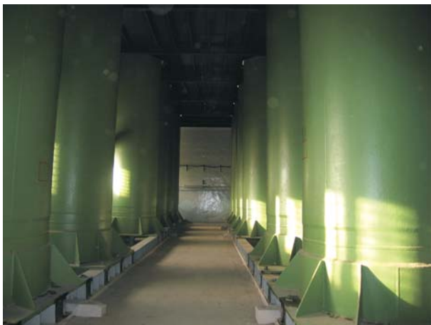
Projekto įgyvendinimo metu parengta visa dokumentacija, reikalinga reaktoriaus avarinio aušinimo sistemos balionų ir kitos Ignalinos AE 117 / 1 pastate esančios įrangos išardymui ir deaktyvacijai
