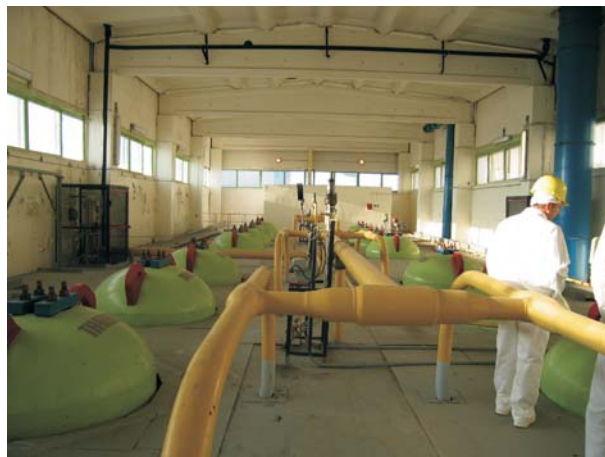
Projekto įgyvendinimo metu parengta visa dokumentacija, reikalinga reaktoriaus avarinio aušinimo sistemos balionų ir kitos Ignalinos AE 117 / 1 pastate esančios įrangos išardymui ir deaktyvacijai
