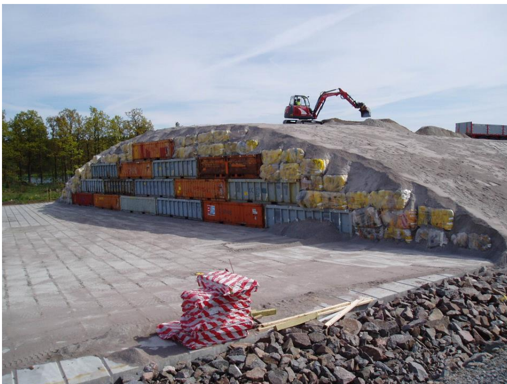
3.2-28 pav. LMRA atliekyno modulyje iš atliekų pakuočių sudaryta struktūra bei ją dengiančių apsauginių inžinerinių barjerų formavimas
