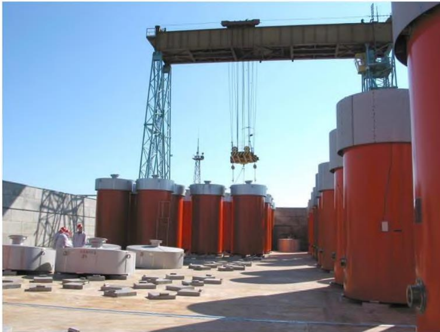
3.2-1 pav. PBK saugyklos LPBKS-1 konteinerių saugojimo aikštelė
