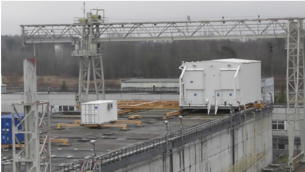
3.2-5 pav. IAE eksploatacijos KRA saugyklos pastatas Nr. 157/1 su G1 ir G2 grupių KRA išėmimo moduliu IM-2
