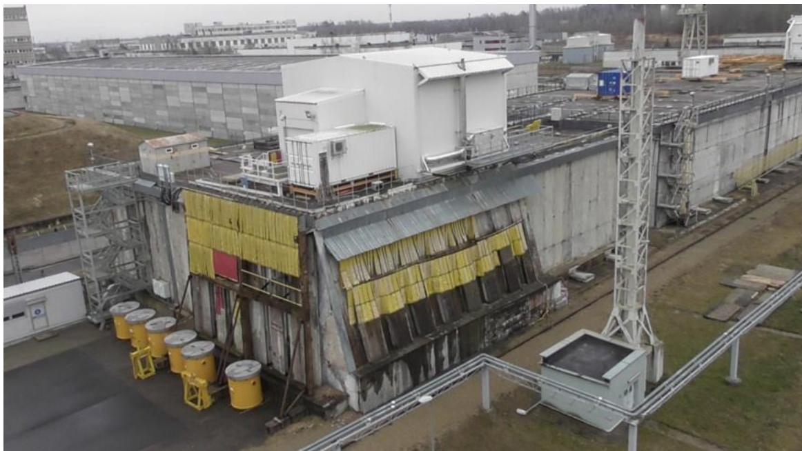
3.2-7 pav. IAE eksploatacijos KRA saugyklos pastatas Nr. 157 su G3 grupės KRA išėmimo moduliū IM-3
