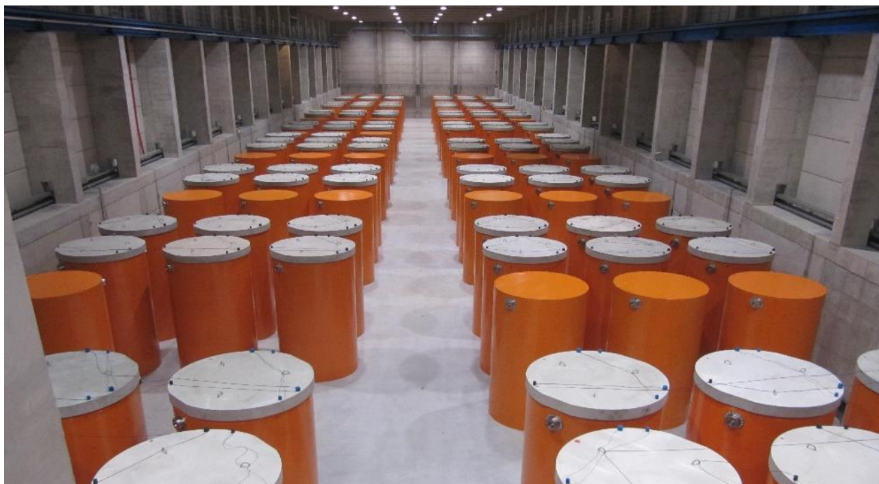
3.2-3 pav. PBK saugyklos LPBKS-2 konteinerių saugojimo salė
