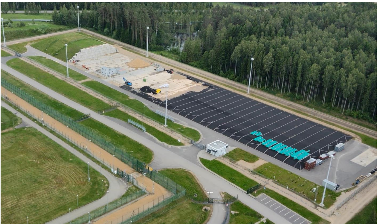
3.2-29 pav. LMRA atliekyno modulis su po atskiros dėjimo kampanijos suformuotais inžineriniais barjeriais ir apsaugine siena
